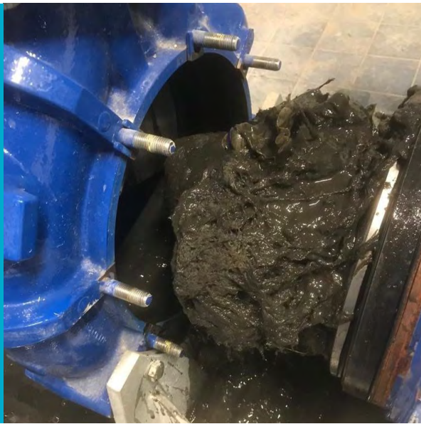
FIGUUR 3-2 EEN 'PROP' BIJ TUSSENGEMAAL EETHEN (BRON: WSRL)
