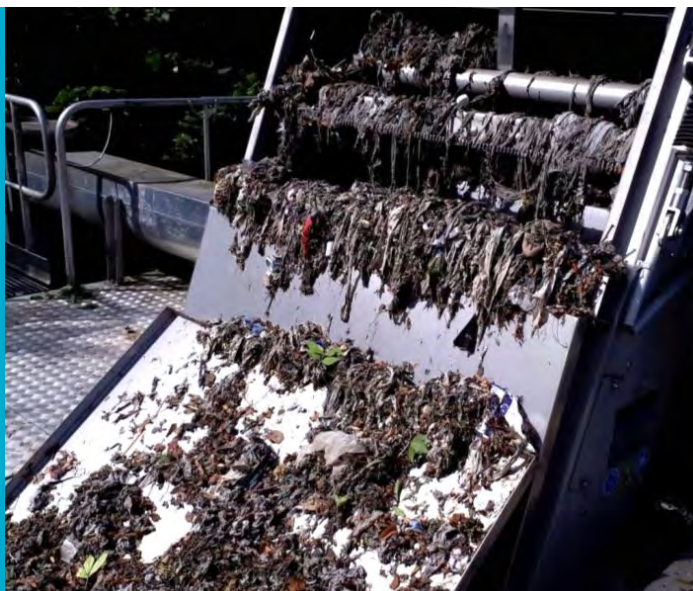
FIGUUR 3-5 ROOSTERGOEDVERWIJDERING RWZI WAALWIJK MET EEN GROTE VERVUILING VAN VOCHTIGE DOEKJES (BRON: WSD)
