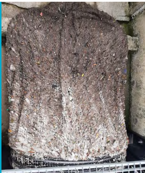
FIGUUR 6-1 VUILFUIK® BIJ EEN RIOOLOVERSTORT IN MAASMECHELEN
