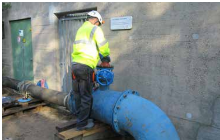
Figuur 3.3 Inbrengen van de Smartball via een sluis die op een T-stuk van de lanceerinrichting is gemonteerd
