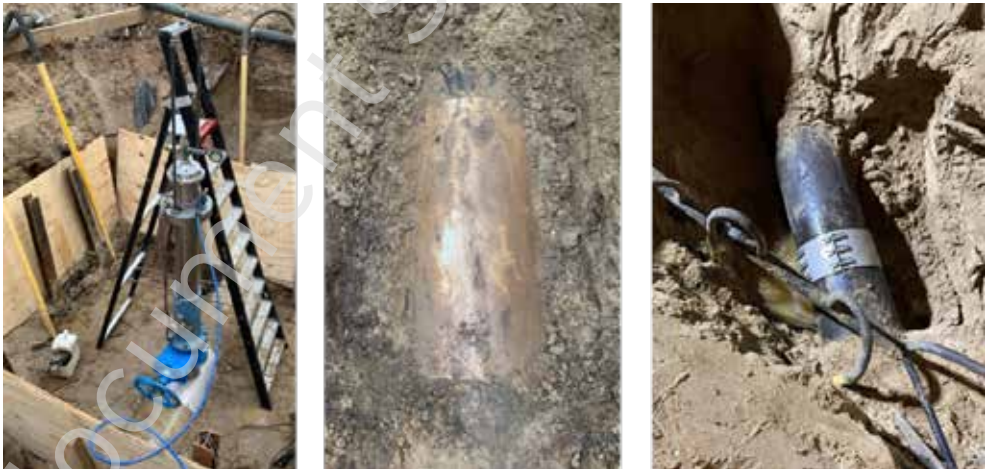
Figuur 4.32 Reparaties aan de persleiding van links naar rechts: Nabij het gemaal is een ballon geplaatst om een afsluiter te plaatsen die later met een reparatieklem is afgesloten (l). Een reparatieklem bij Croydonplein (m). Een reparatieklem nabij buisdeel 134 waar een sondering dwars door de leiding is gegaan (r).
