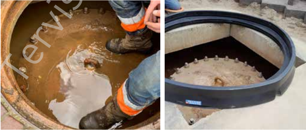
Figuur 2.6 Ontvangstput met geknevelde afdekking (l), waarvan de putdeksel vergroot is zodat de afdekking door de putrand past en kan worden verwijderd (r)
