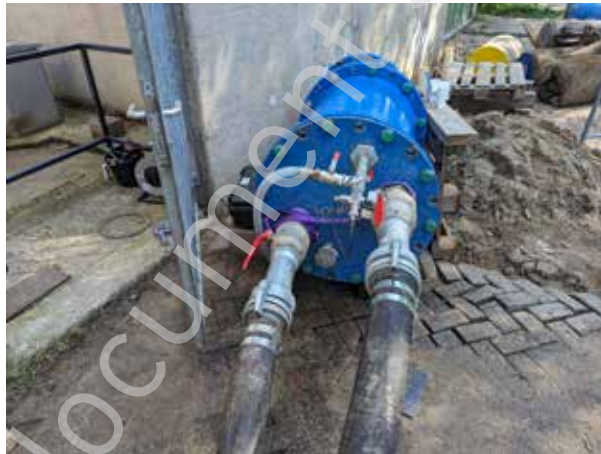
Figuur 3.8 Lanceerinrichting nadat de Acquarius is ingebracht, inclusief de toevoerslangen van de tijdelijke pompinstallatie
