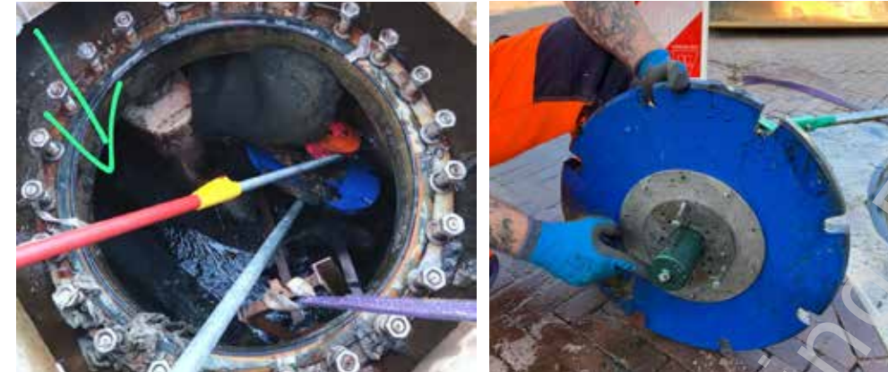
Figuur 3.9 Reinigingspig komt aan bij de ontvangstput met daarvoor de vervormde reinigingspig en afgebroken centreerschijf (l). Rechts de centreerschijf
