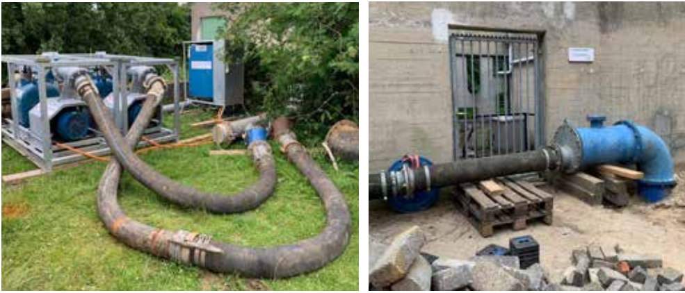
Figuur 2.5 Tijdelijke pompinstallatie (l) met aansluiting op de lanceerinrichting (r).
