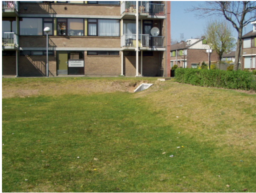
Figuur 6.8 Uitstroom bij flatgebouw.
