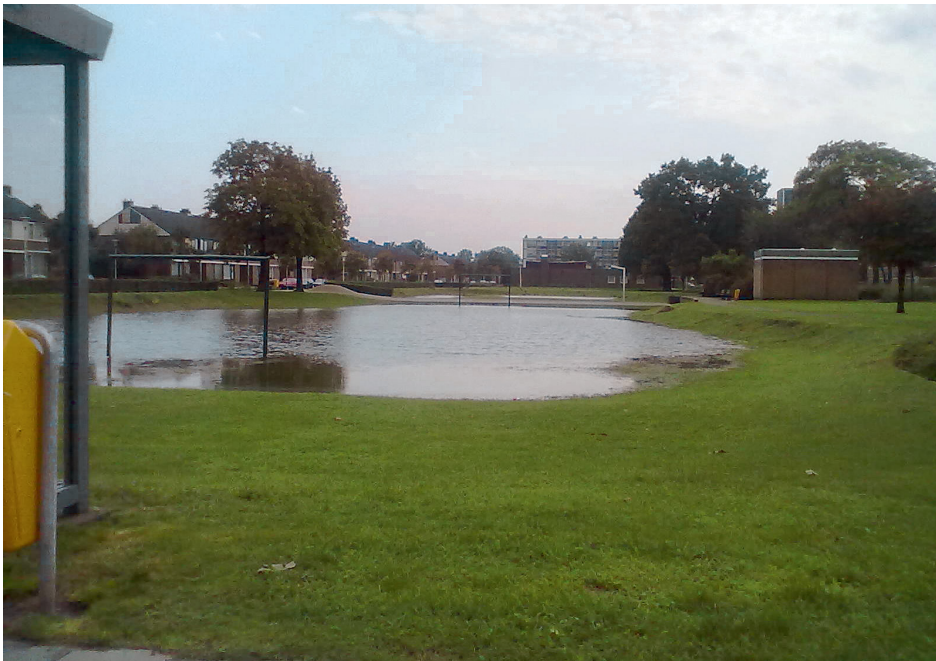
Figuur 6.6 Speelveld in gebruik voor waterberging.
