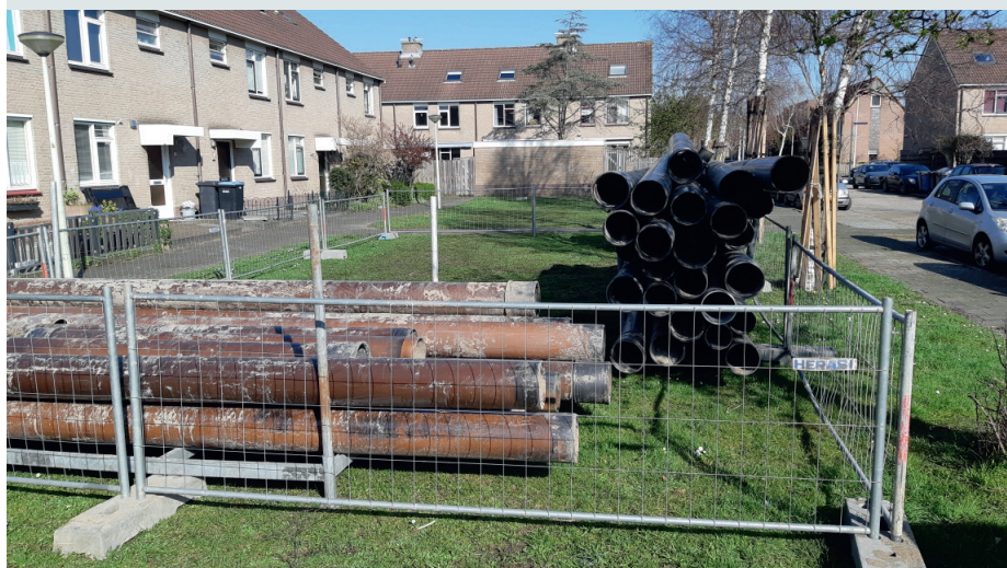
Opslag van gebruikte PVC-buizen in Zaanstad om weer in een andere straat teruggelegd te worden.
