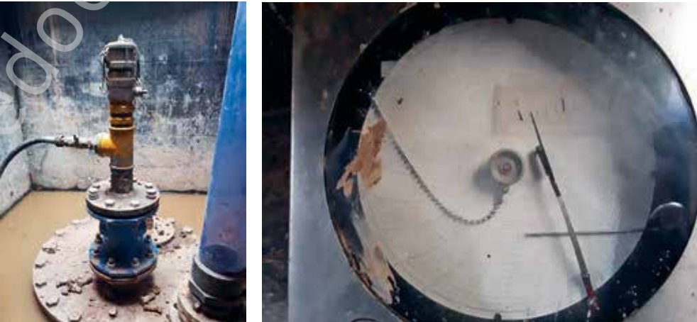
Figuur 4.19 Drukmeting op afsluiter (links) en schrijvende meter (rechts)
