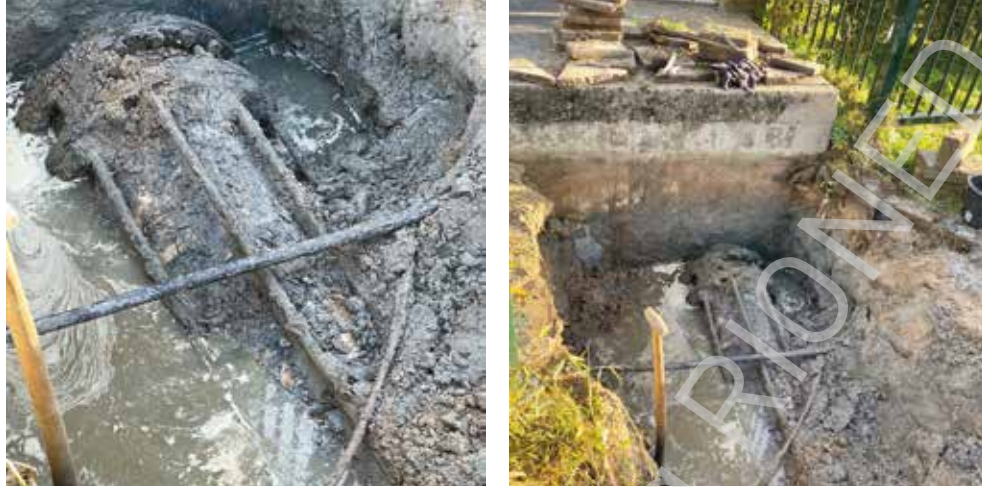
Figuur 5.10 Proefsleuf met pendelstuk
