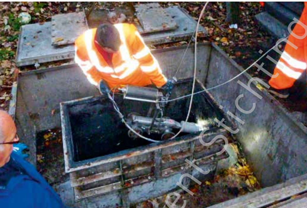
Figuur 5.3 Inbrengen inspectieapparatuur. Foto Waterschap Brabantse Delta.
