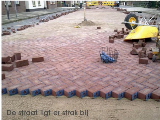
Aanleg gebakken keien met drainvoeg
