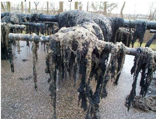
Vervuilde beluchtungsuisen op rwzi Beemster
