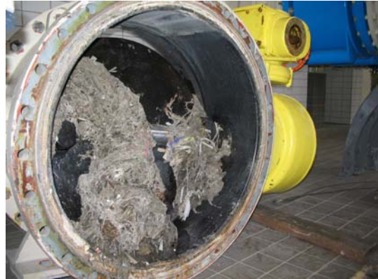
Door doekjes en vezels verstopte vlinderklep
