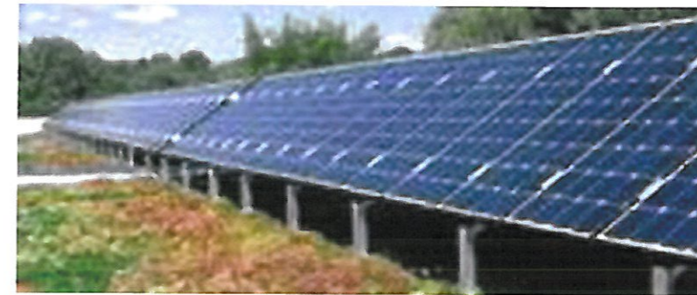
Sedumdak gecombineerd met zonnepanelen
