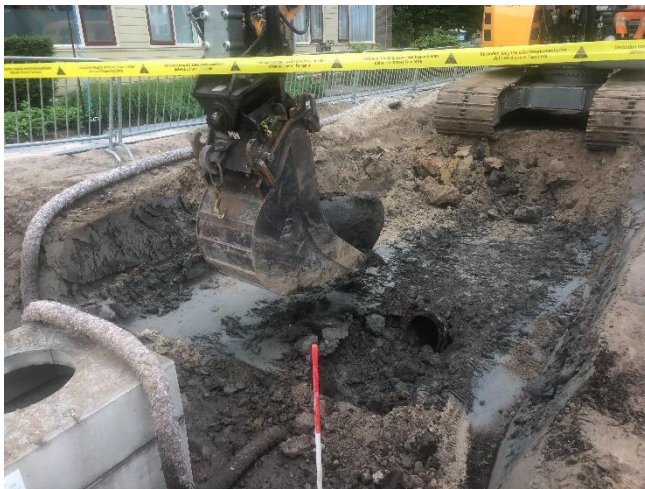
Foto bijlage: Machinale verwijdering meterse eibuis met asbestkit.
